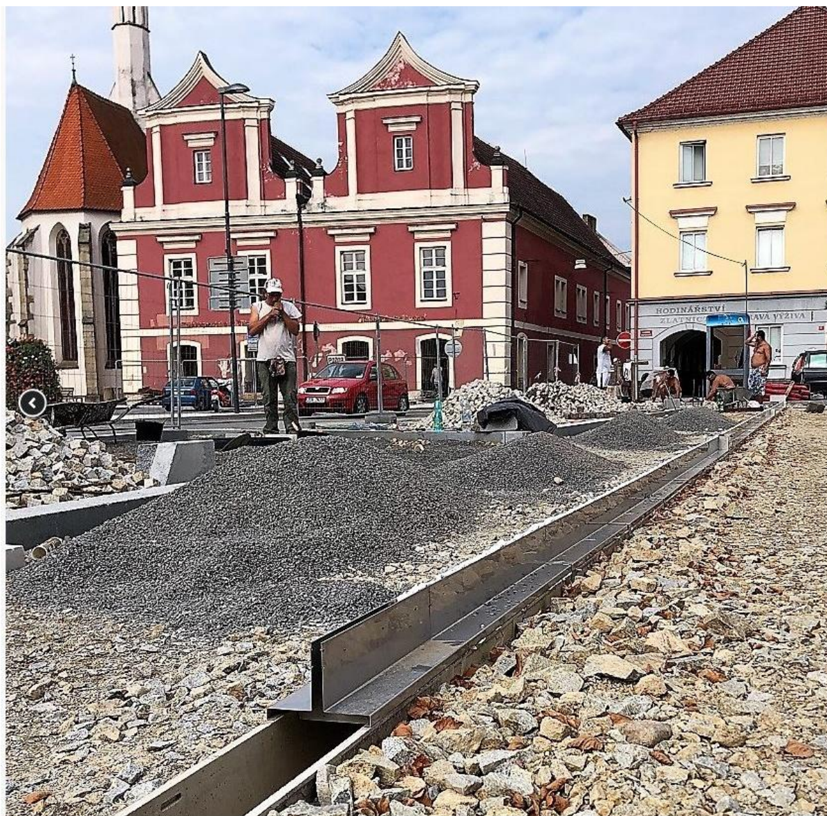
ilustrační foto liniového žlabu se středním atypickým nerezovým štěrbinovým krytem
